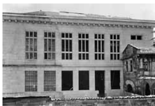
Figura 4 – Sociedade Martins Sarmiento, fachada posterior/oeste.
